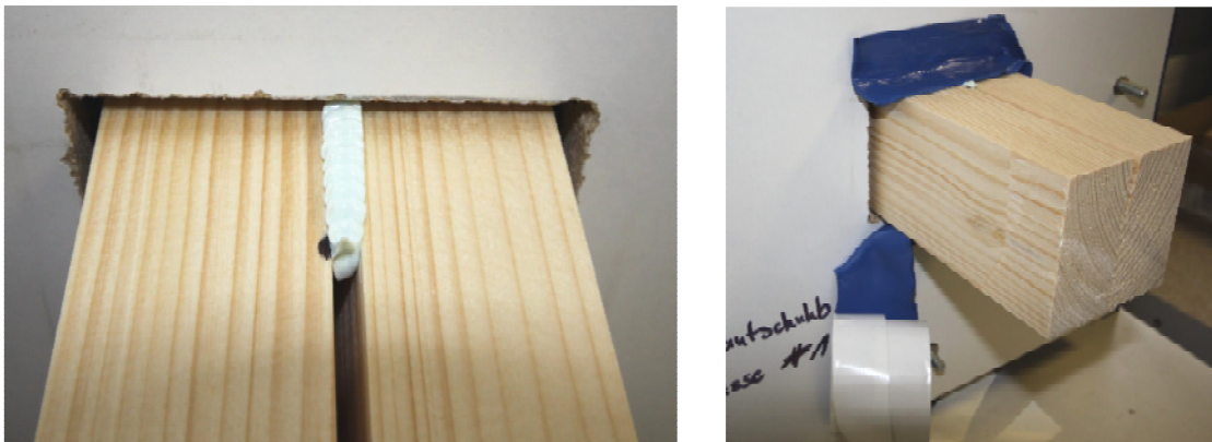
Abbildung 19: Ausgespritzter Riss mit geringer Eindringtiefe der Dichtmasse (links) und Aufbringen des Butylkautschukklebebandes (rechts)
