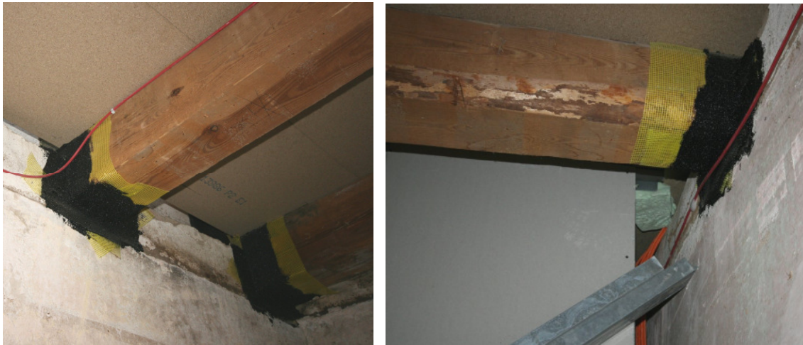
Abbildung 31: Beispiel für den Einsatz der Dickbeschichtung zur Balkenabdichtung im Sanierungsprojekt „Schloss Wartin“ [Hasper 2010]
