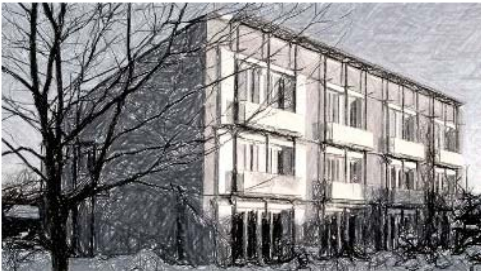
Abbildung 1: Das Passivhaus Kranichstein ist ein solaroptimiertes Reihenendhaus mit 156 m 2 Wohnfläche auf 2,5 Geschossen
