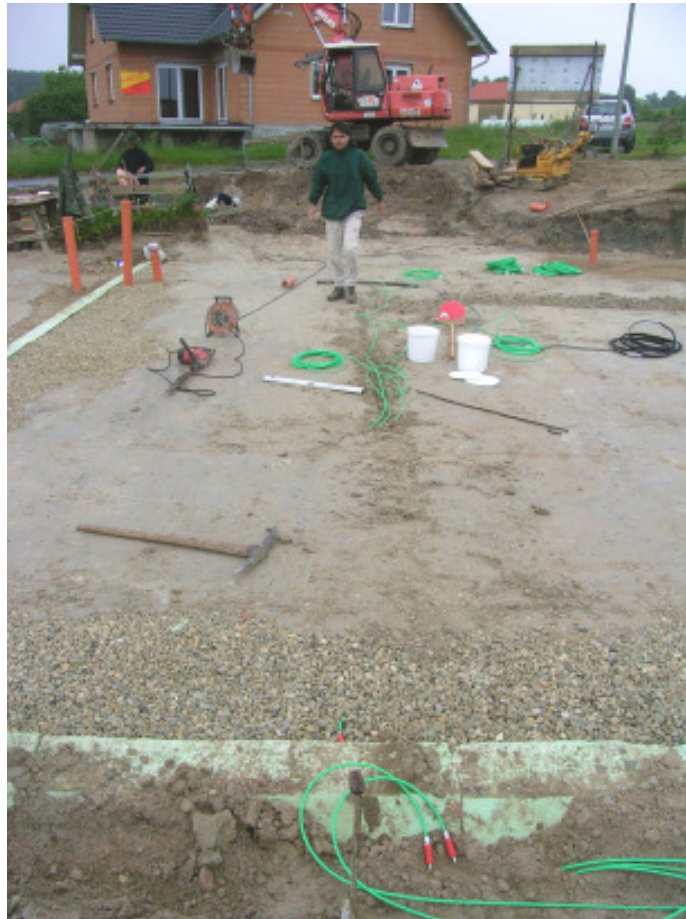
Abbildung 28: Verlegung der Temperatursensoren durch PHI Mitarbeiter vor dem Aufbringen der Sauberkeitsschicht. Bei den grünen Kabeln handelt es sich um die Sensor-kabel, die roten Kabelenden enthalten die vergossenen Sensoren.
