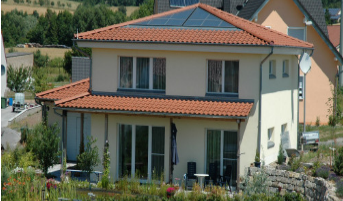
Abbildung 1: Südfassade des Gebäudes. Auf dem Süddach befindet sich die dreieckige thermische Solaranlage (Foto: Houwen).
