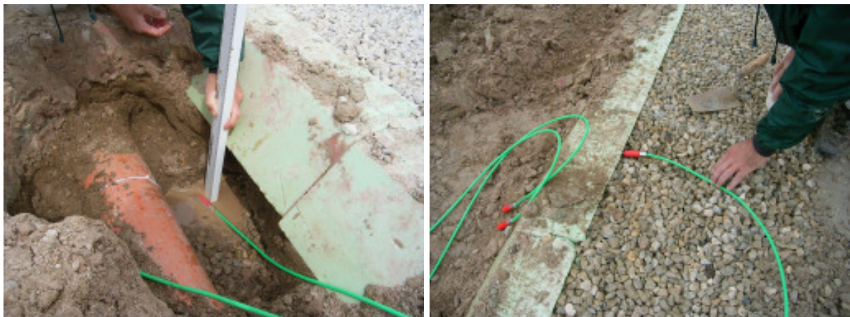
Abbildung 29: Verlegung der Temperatursensoren unterhalb und am oberen Rand der Dämm-schürze. Die sichtbaren Kieselsteine bilden die Oberfläche der sogenannten Schotterkeule.
