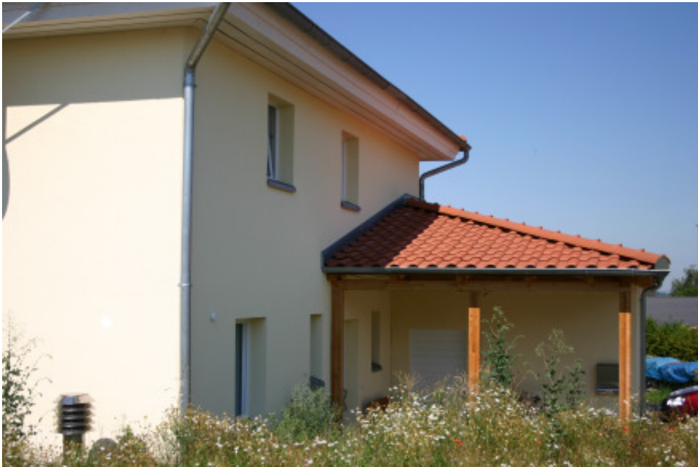
Abbildung 4: Eingangsbereich des Gebäudes auf der Nordseite, dahinter die vorgelagerte Doppelgarage. Links im Bild befindet sich die Fortluftausblasöffnung.
