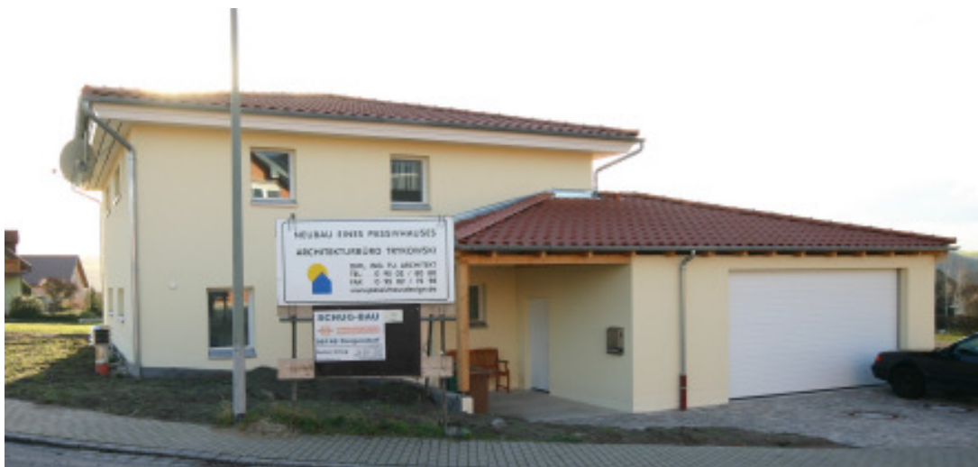
Abbildung 5: Gebäude von Norden (Eingangsbereich und Doppelgarage).
