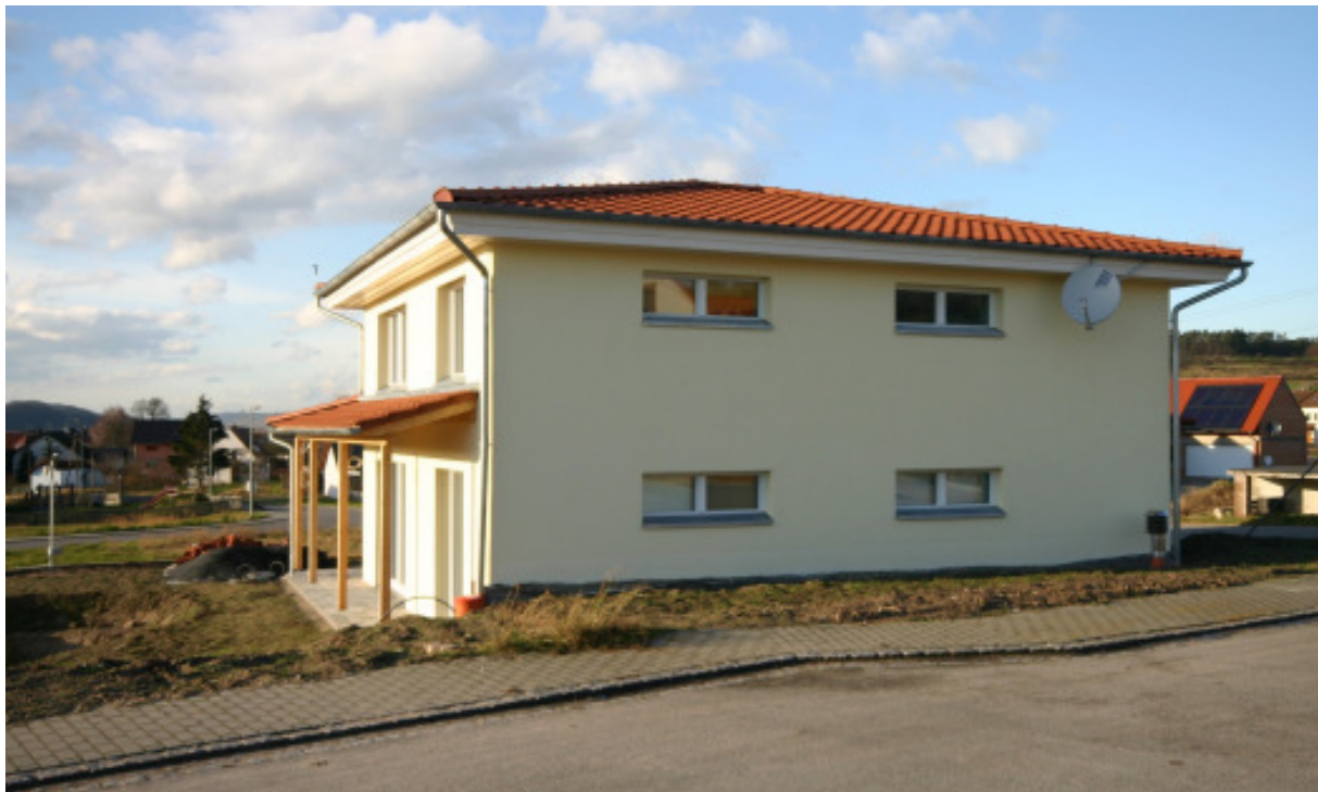
Abbildung 3: Gebäude von Osten gesehen.
