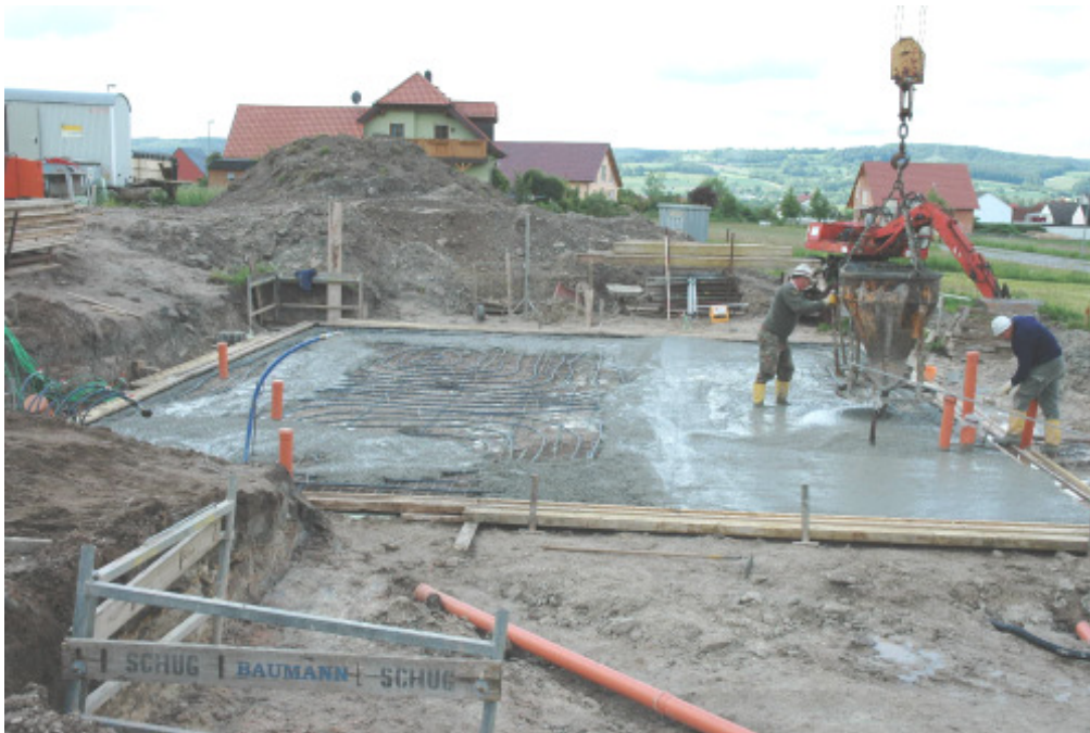
Abbildung 13: Herstellen der Sauberkeitsschicht mit den verlegten Solewärmetauscher-Rohren (Foto: Houwen).
